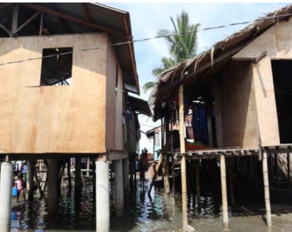
Sama Badjao bauen schrittweise ihre Häuser wieder auf, im Vergleich die alte Bambusstelzenbauweise vs. die neuen Betonstelzen.
