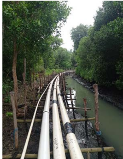
Für die Anzucht wird viel Meerwasser benötigt, das durch Rohre angepumpt wird. Foto: Pambudi Septiadi
