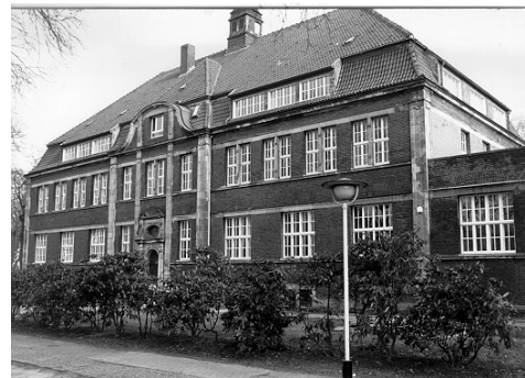
Das Asienhaus hat seinen Sitz im ehemaligen Verwaltungsgebäude der Zeche Zollverein in Essen
